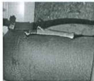
图 6 回水温度传感器
